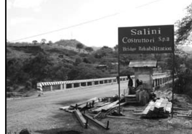
Nella foto: cantiere per il ripristino di un ponte sul fiume Gibe danneggiato durante i lavori di costruzione
